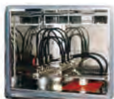
槽内软管安装状态
